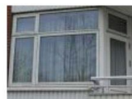
Eksempel på altanvinduesparti på blok 1
