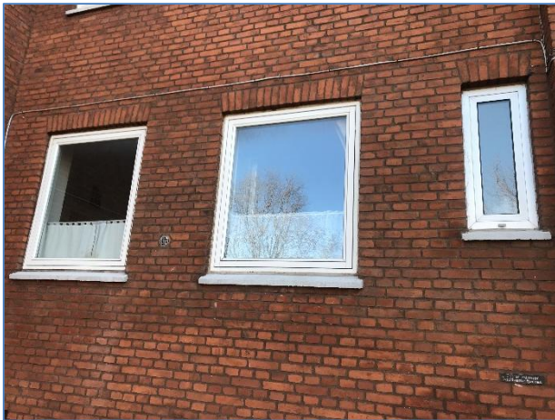
Foto 1: Vindue til bolig
