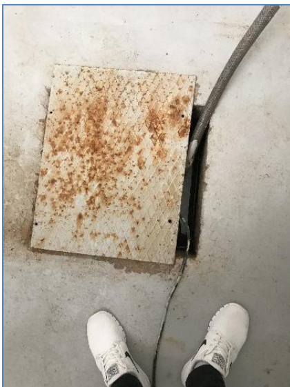
Foto 5: Gulv afløb i kælder
