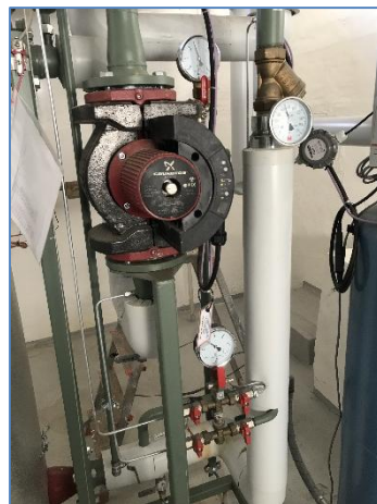
Foto 2: Cirkulationspumpe
