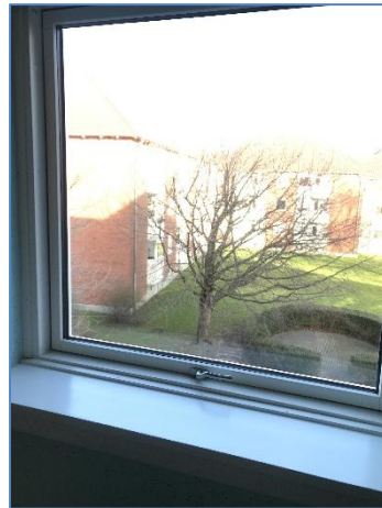
Foto 2: Vindue i opgang
