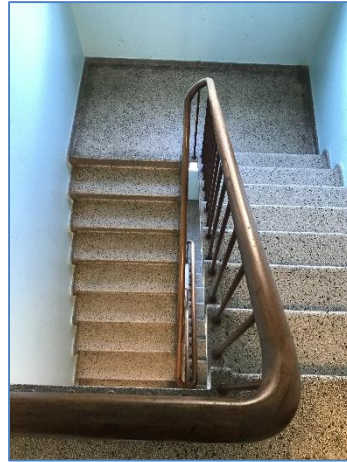
Foto 2: Trappeløb på hovedtrappe
