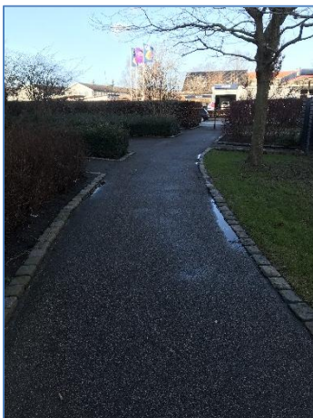
Foto 3: Transportvej til hovedvej
