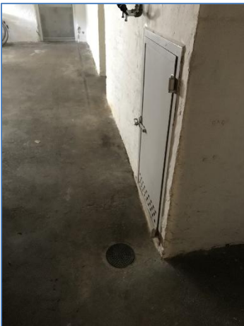
Foto 3: Gulvafløb i kælder
