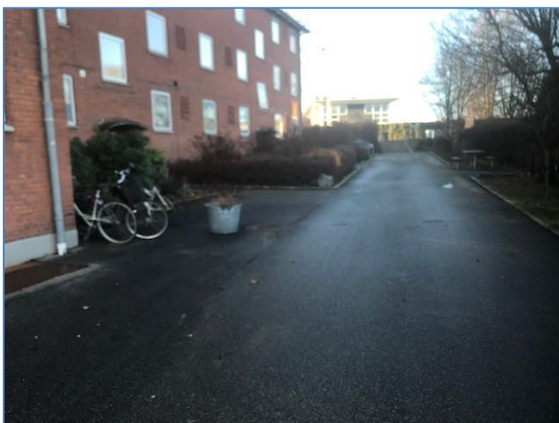
Foto 5: Belægning foran indgange
