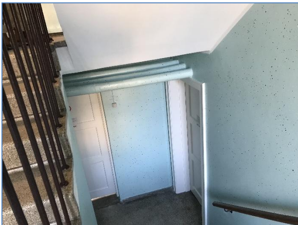
Foto 3: Kælderdøre i opgang
