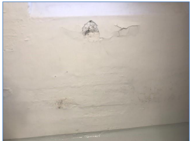
Foto 4: Kældervæg afskalning
