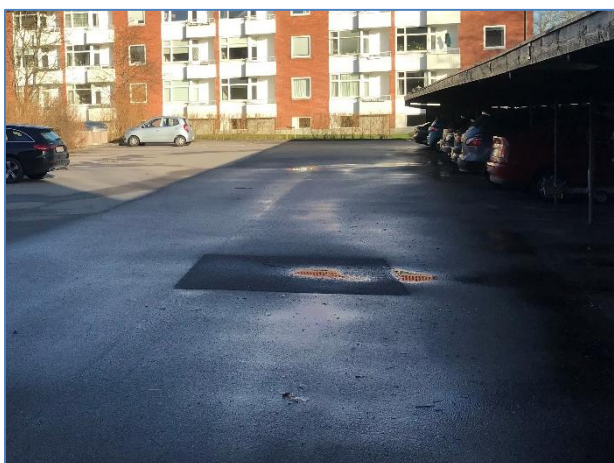
Foto 3: Ristafløb foran overdækket parkering
