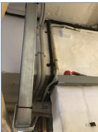
Foto 5: Kabelbakke i kælder
