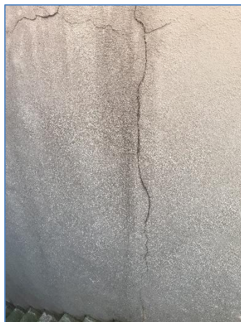
Foto 2: Sætningsskader kældernedgang
