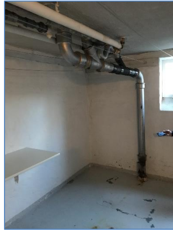
Foto 2: Faldstamme i kælder
