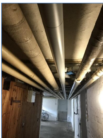
Foto 5: Rørføringer gennem kælderloft
